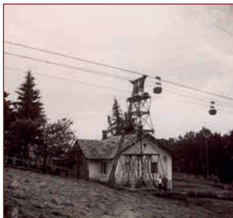
Vasérc szállítása a szirk-likieri drótkötélpályán
